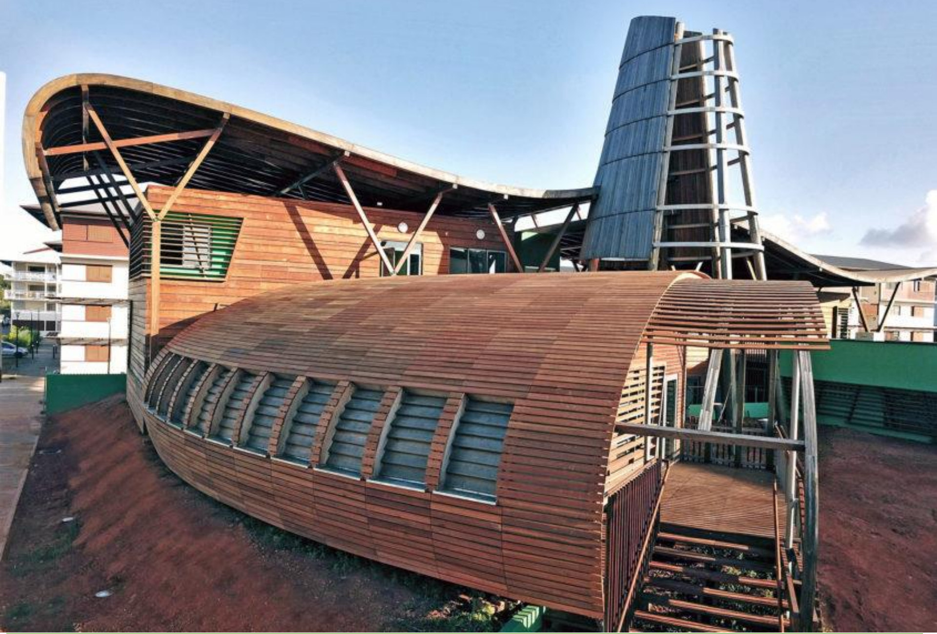
Image : GAIA Architecture – La maison du bois à Cayenne
