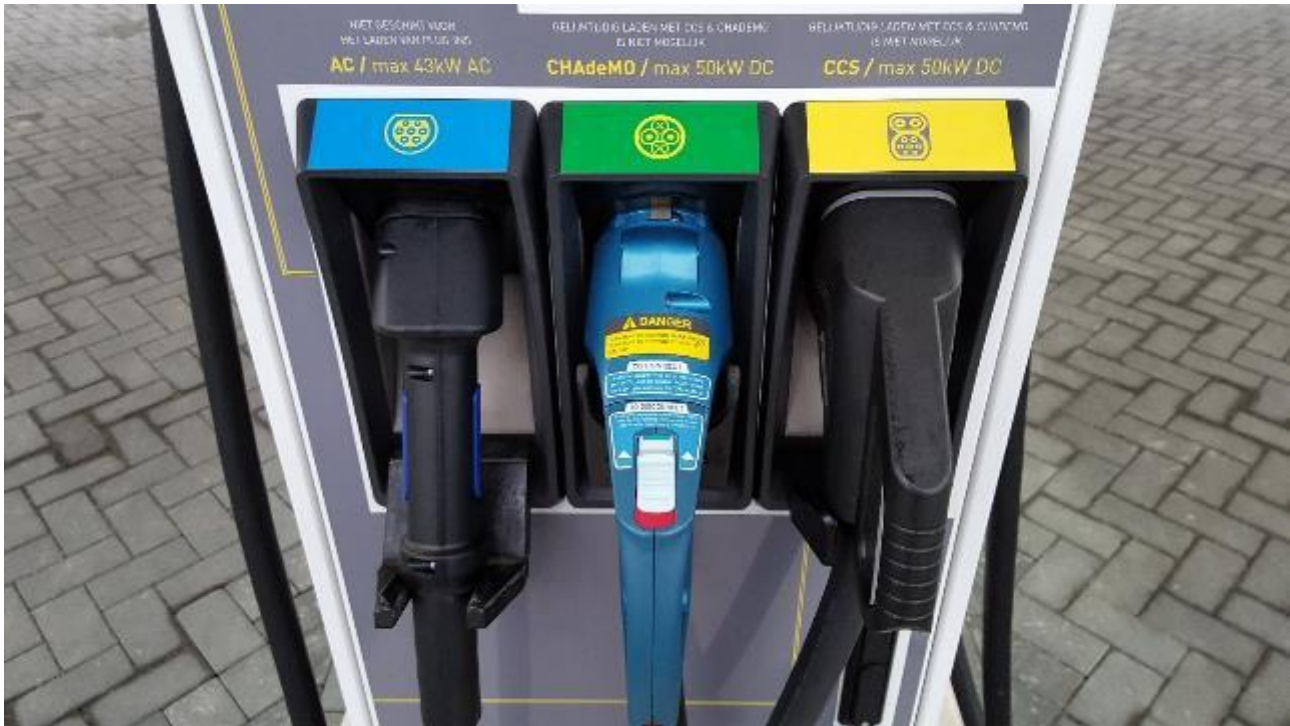
Figure 47 : Les prises constituant une charge rapide : Type 2, Type CHAdeMO, Combo
