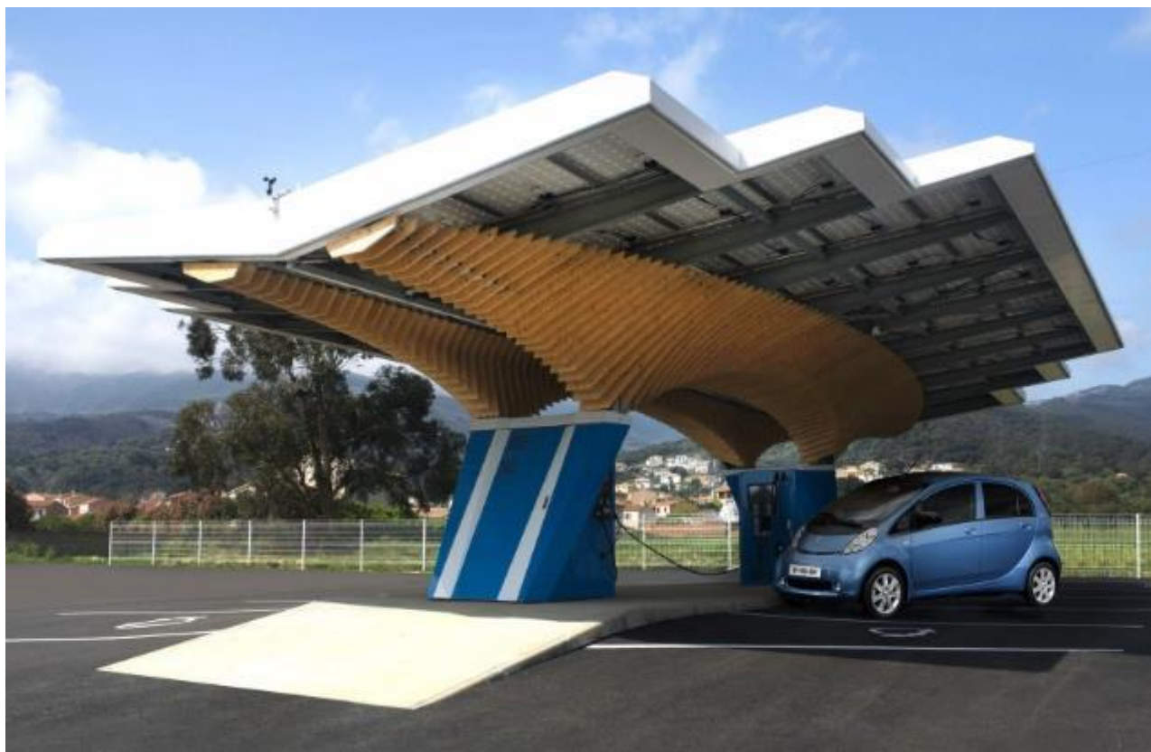
Figure 96 : Station Driveco en Corse : recharge VE à énergie renouvelable avec appoint réseau
