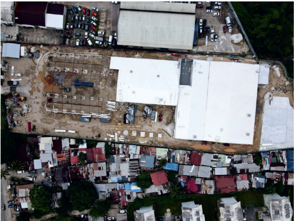
Vue aérienne de la construction d'un supermarché à Saint-Laurent © Mathis CHELIM - Orphose Studio
