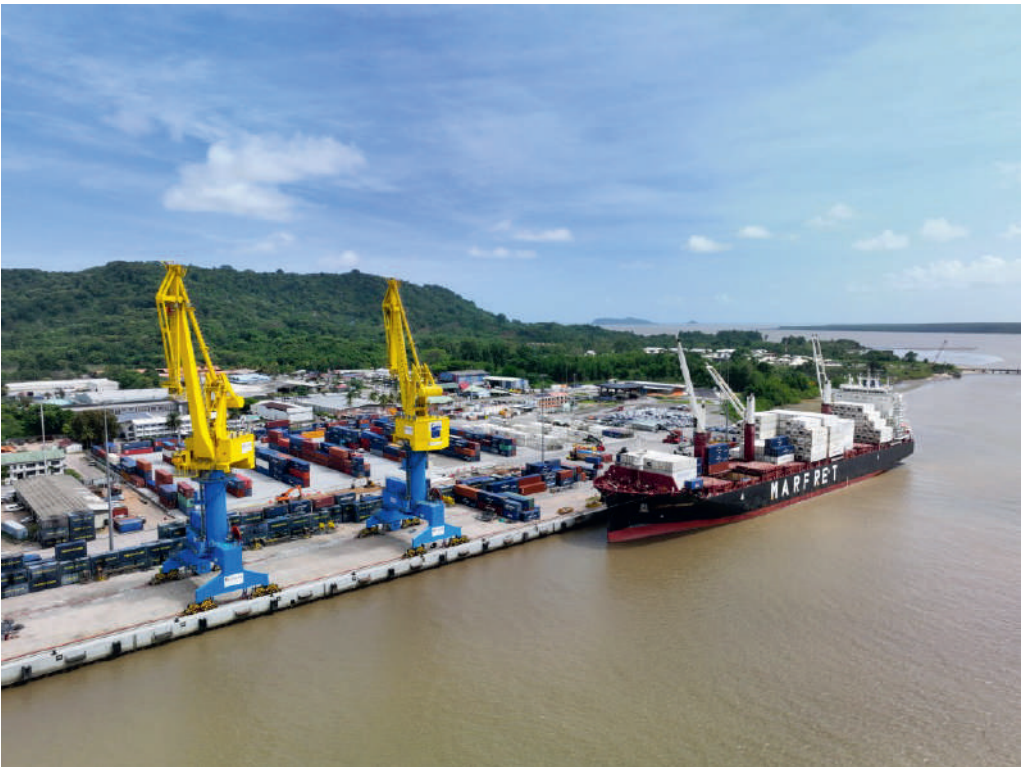
Grues installées au port de Dégrad-des-Cannes © Grand Port Maritime de Guyane
