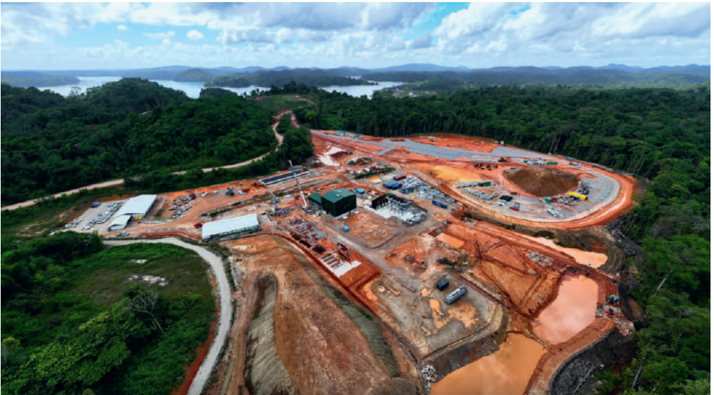
Pôle scierie et énergie de Petit-Saut en construction © Brahim MOUNTIJ - Voltalia
