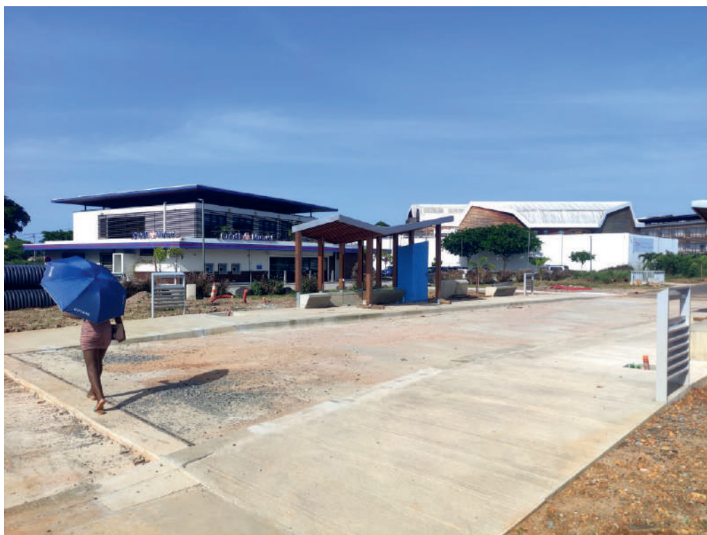
Voie en construction dans le quartier Eau Lisette pour accueillir le futur TCSP © Santi CALVO-CANO
